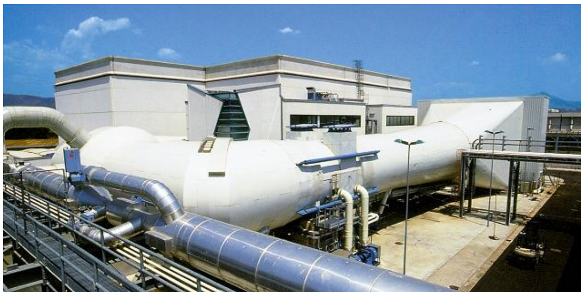
Рисунок 1.4 — Аэродинамический комплекс для исследования обледенения конструкций CIRA (IWT Icing Wind Tunnel)
